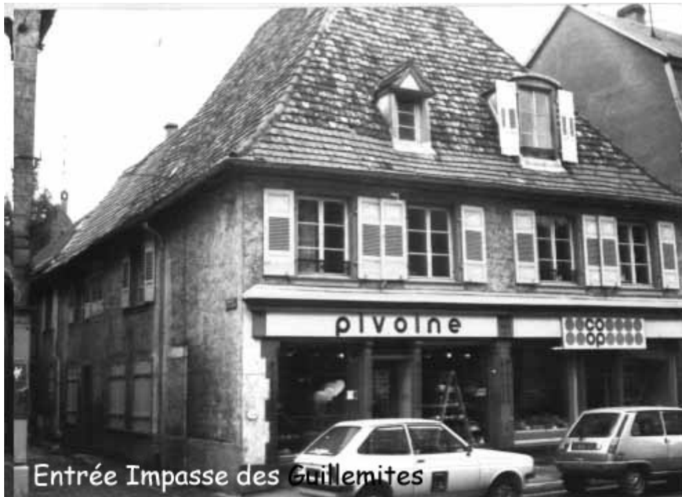
Maison de l'ancêtre telle qu'elle se présente actuellement (1978) depuis la Grande Rue et l'impasse des Guillemites
